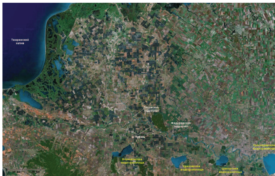
Рисунок 2. Космоснимок наиболее значимых гидротехнических сооружений Нижней Кубани Figure 2. Satellite image of the most significant hydraulic structures in the Lower Kuban
