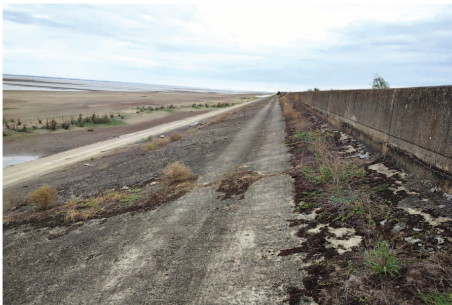
Рисунок 2. Оградительная плотина инженерной защиты долины р. Псекупс. Вид закрепленного железобетонными плитами верхового откоса Figure 2. Protective dam of engineering protection of the valley of the Psekups river. View of the upper slope fixed with reinforced concrete slabs
