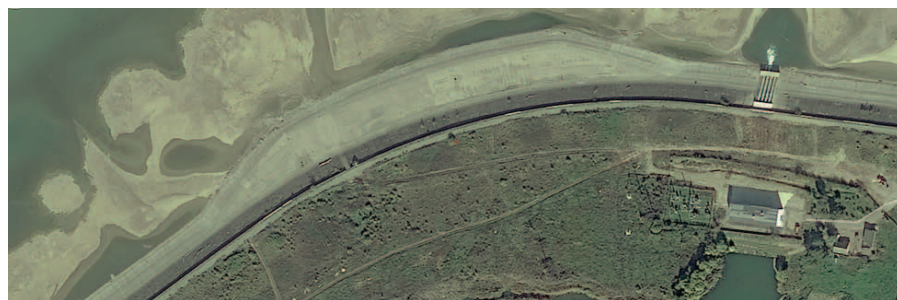
Рисунок 4. Берма оградительной плотины инженерной защиты долины р. Псекупс Figure 4. Berm of the protective dam of engineering protection of the Psekups river valley
