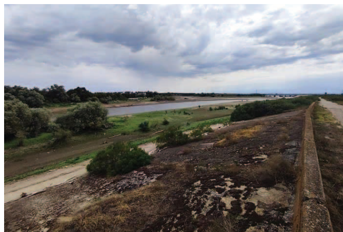
Рисунок 2. Оградительная плотина инженерной защиты долины р. Псекупс. Вид закрепленного железобетонными плитами верхового откоса Figure 2. Protective dam of engineering protection of the valley of the Psekups river. View of the upper slope fixed with reinforced concrete slabs
