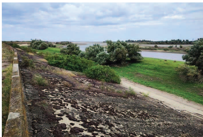
Рисунок 3. Участок плотины ПК 54-60, где толщина плит составляет 0,16 м Figure 3. Section of the PK 54-60 dam, where the thickness of the plates is 0.16 m
