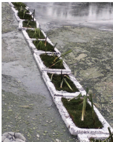
Рисунок 9. Установка биоплато Figure 9. Installing a bioplate
