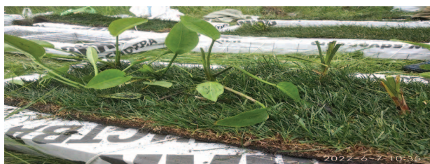
Рисунок 8. Этапы монтажа биоплато Figure 8. Stages of installation of the bioplat
