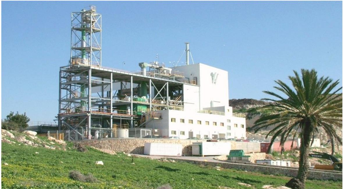
Рисунок 5. Установка плазменной газификации и плавления, (Хайфа, Израиль)
