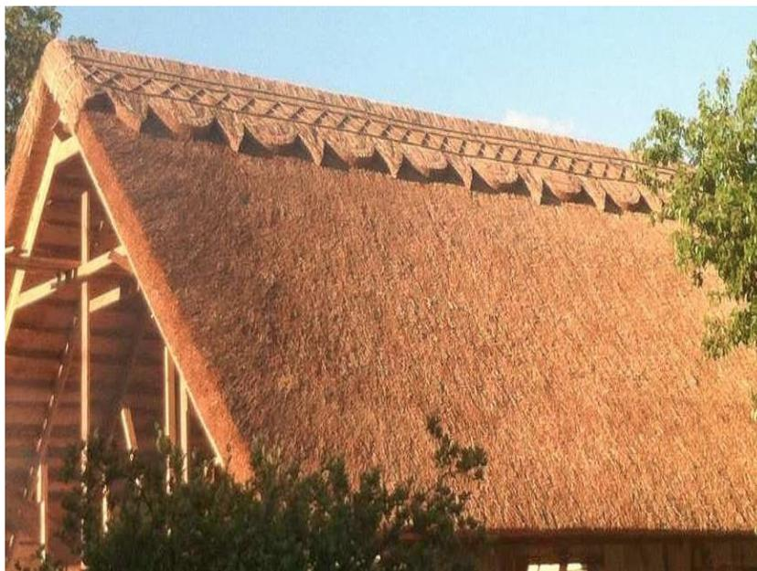
Рис.5. Камышовая (тростниковая) кровля
