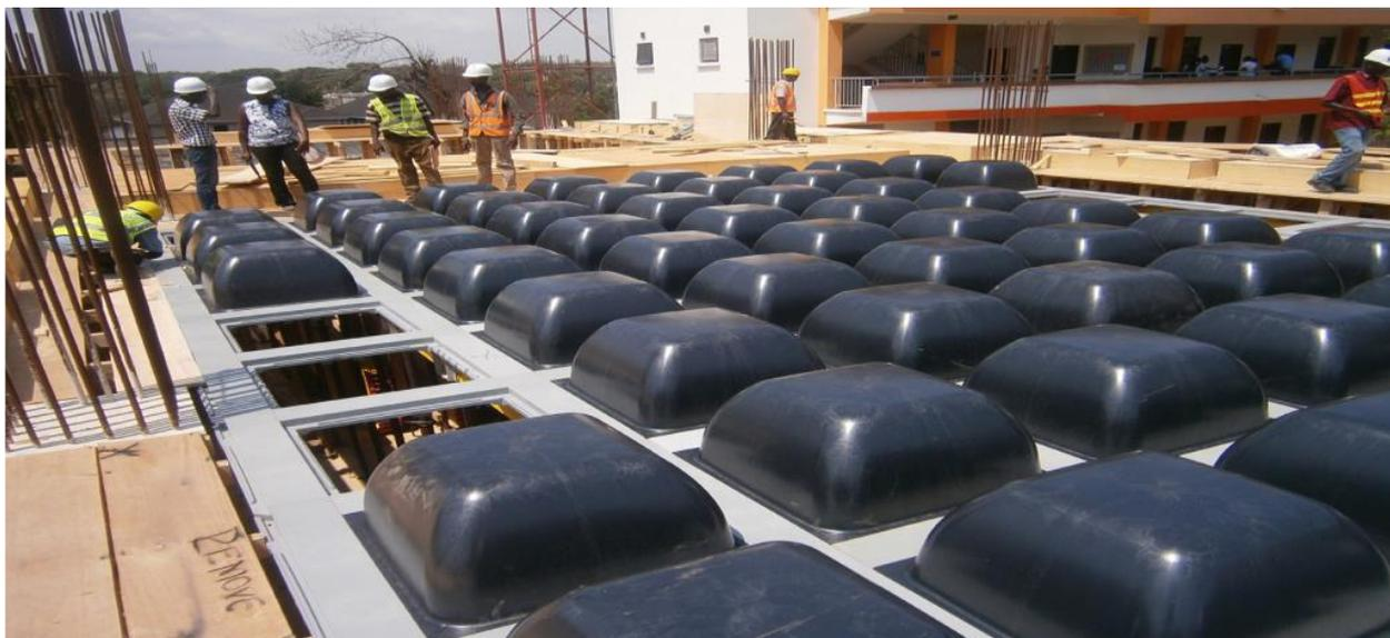
Рисунок 3. Кессонная опалубка типа «Skydome»
