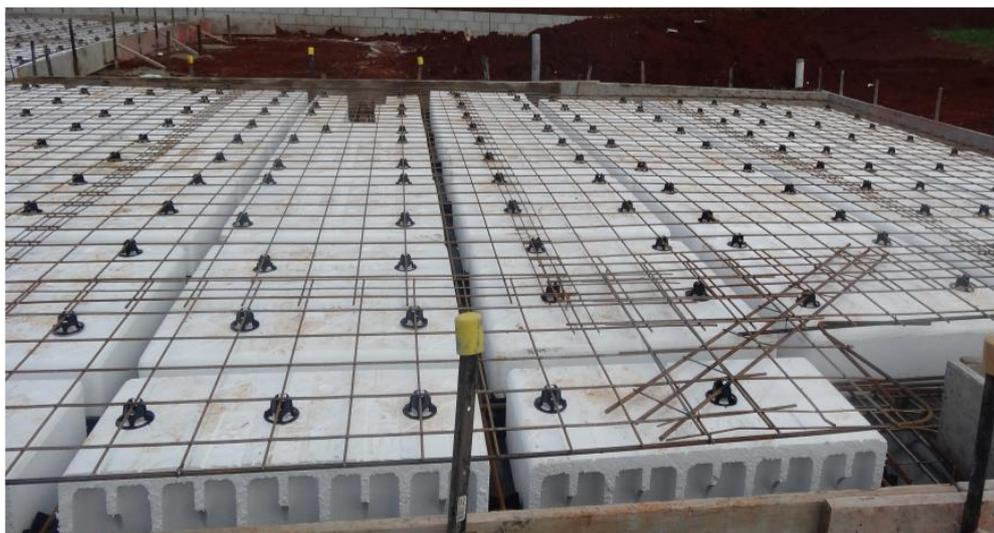
Рисунок 4. Сборно-монолитный кессонные перекрытия
