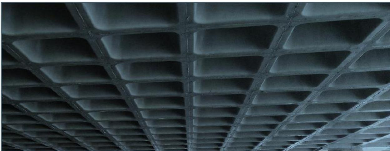
Рисунок 1. Внешний вид облегченного безбалочного перекрытия
