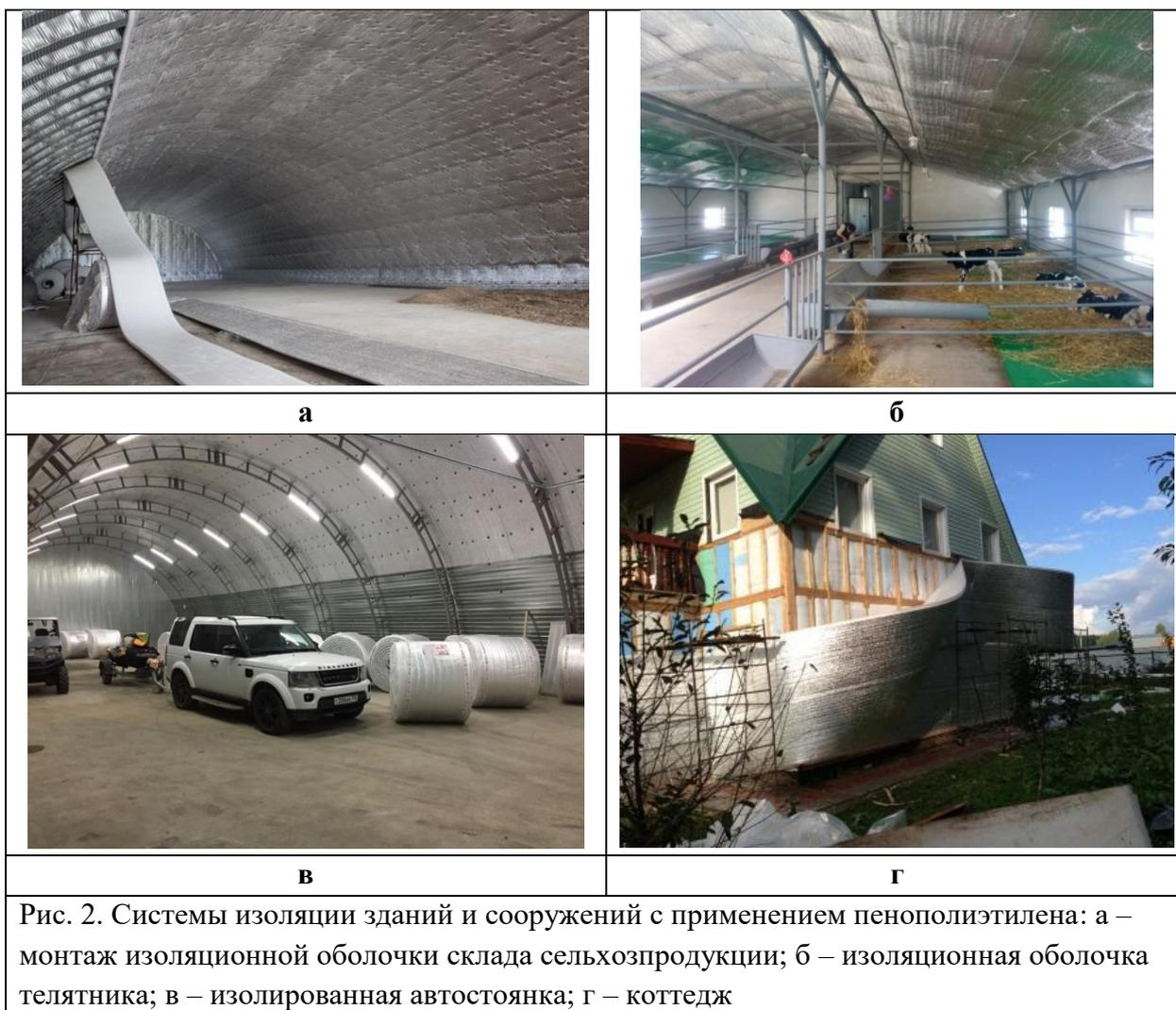
Применение замкового сварного соединения рулонов пенополиэтилена позволяет получить изоляционную оболочку скатной кровли без применения дополнительной ветрозащиты и пароизоляции. При этом для надежной бесшовной сварки мест стыков обрешётку для крепления изоляционного полотна следует располагать непосредственно под замковой системой утеплителя.
