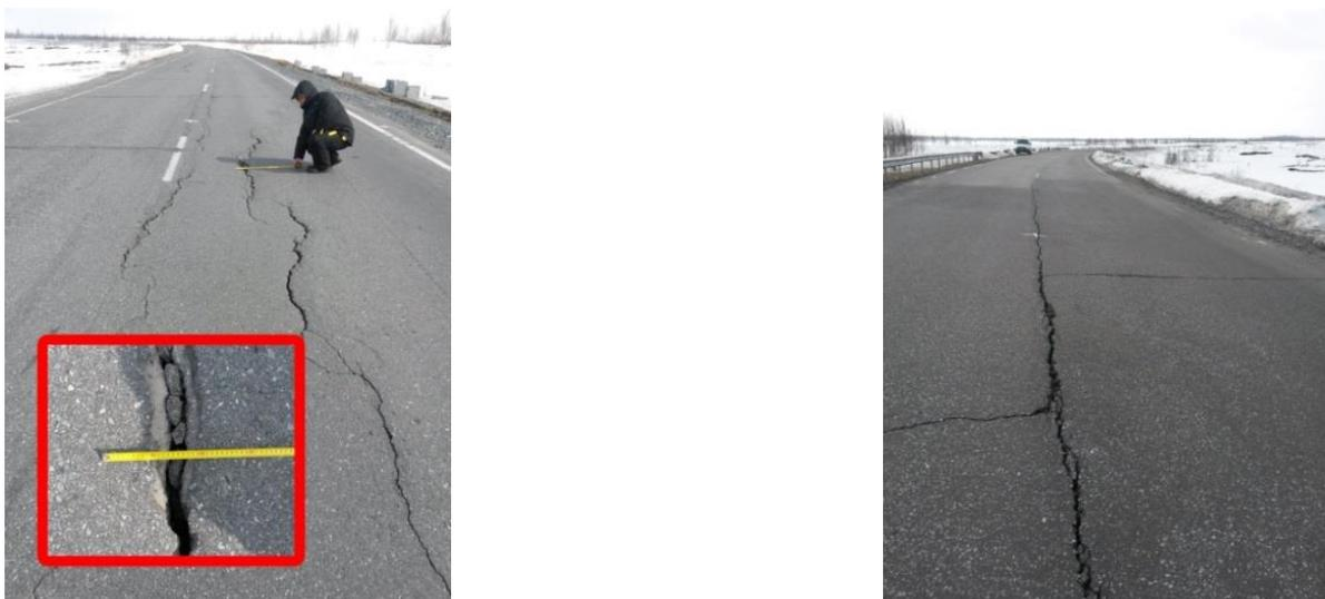
Рисунок 2. Фотофиксация развития продольных и поперечных трещин
