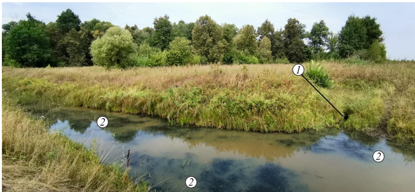
Рисунок 3. Участок магистрального канала: 1 – трубчатый регулятор; 2 – заросли элодеи канадской ( Elodea canadensis )
