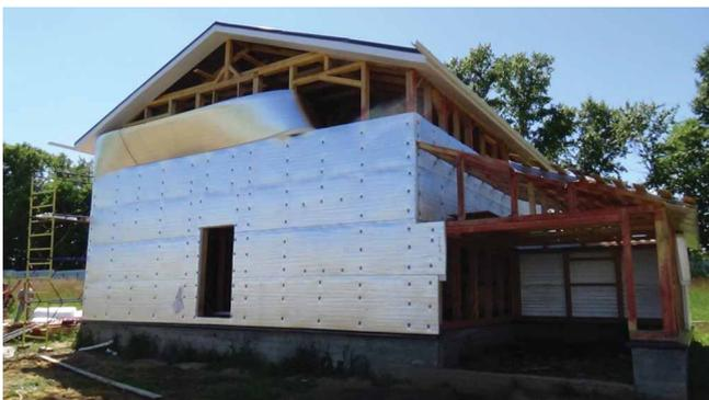
Рис. 4. Изоляция дома каркасного типа (общий вид и оконный проем)
