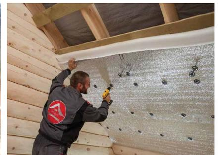
Рис. 4а. Изоляция кровли (закрепление рулонного пенополиэтилена саморезами со шляпкой по деревянной обрешетке)
