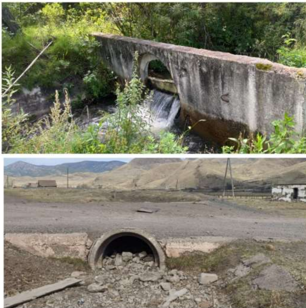
Рисунок 1 - Сооружения на внутрихозяйственных системах
