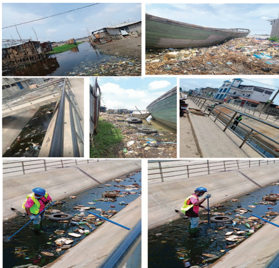
Рисунок 5. Состояние дренажной инфраструктуры на озере Нокуз Figure 5. State of drainage infrastructure on Lake Nokoué
