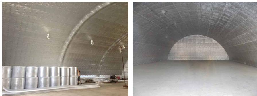
Рис. 2. Изоляция бескаркасного помещения. Крытый скотный двор
