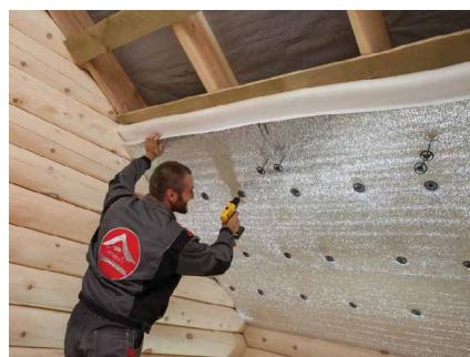
Рис. 4а. Изоляция кровли (закрепление рулонного пенополиэтилена саморезами со шляпкой по деревянной обрешетке)
