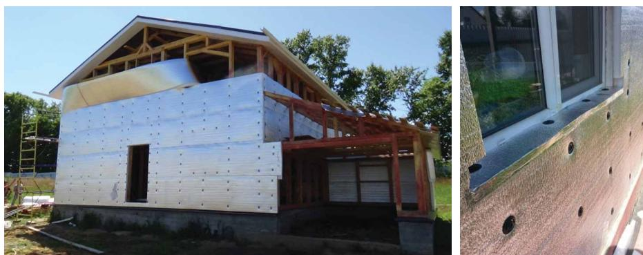
Рис. 4. Изоляция дома каркасного типа (общий вид и оконный проем)
