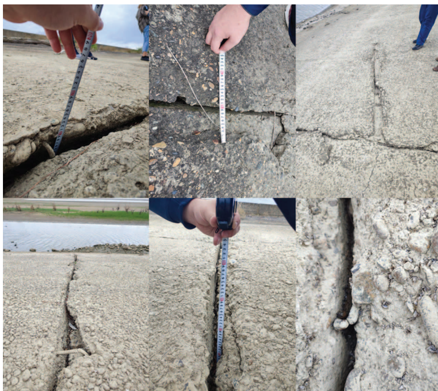
Рисунок 6. Типичные разрушения швов на оградительной плотине инженерной защиты долины р. Псекупс, Краснодарского водохранилища Figure 6. Typical destruction of seams on the protective dam of engineering protection of the valley of the Psekups river, Krasnodar reservoir
