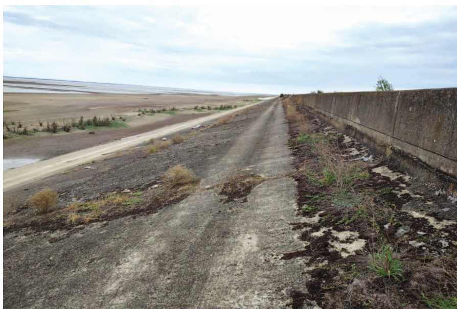
Рисунок 2. Оградительная плотина инженерной защиты долины р. Псекупс. Вид закрепленного железобетонными плитами верхового откоса
