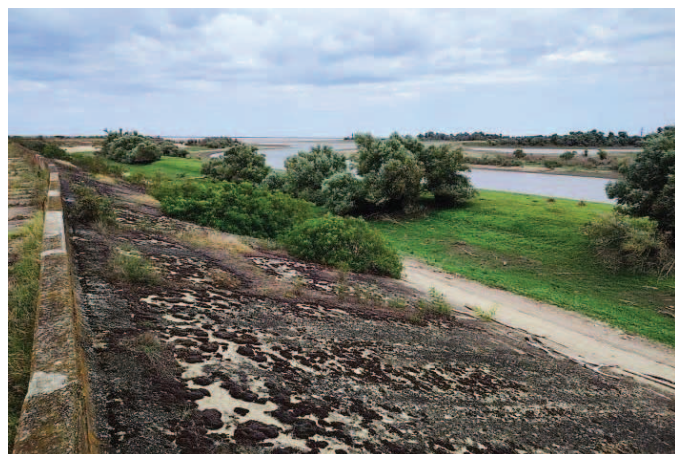
Рисунок 3. Участок плотины ПК 54-60, где толщина плит составляет 0,16 м
