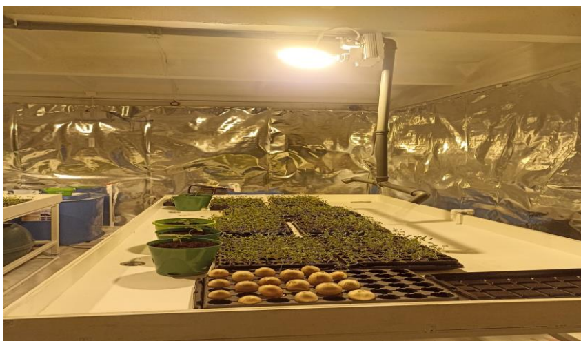
Рисунок 11. Газоразрядные натриевые лампы, мощностью 400Вт, световой поток 46000 Лм.
