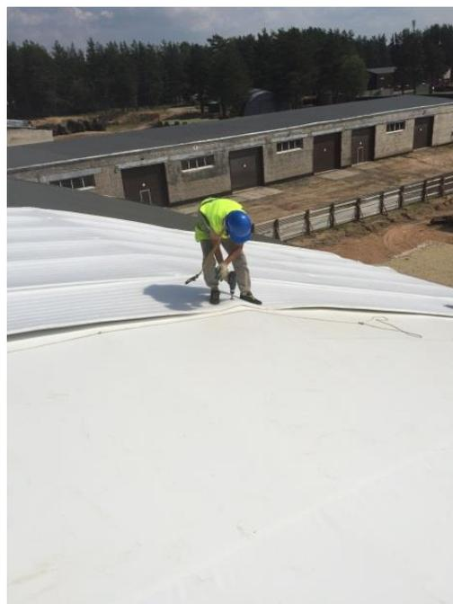
Рис. 3. Монтаж тентового покрытия
