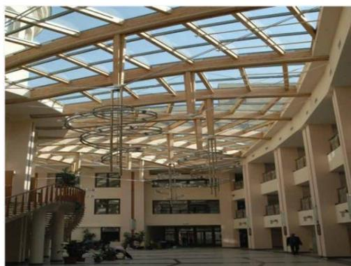
Рис. 1. Большепролетные клееные деревянные конструкции
