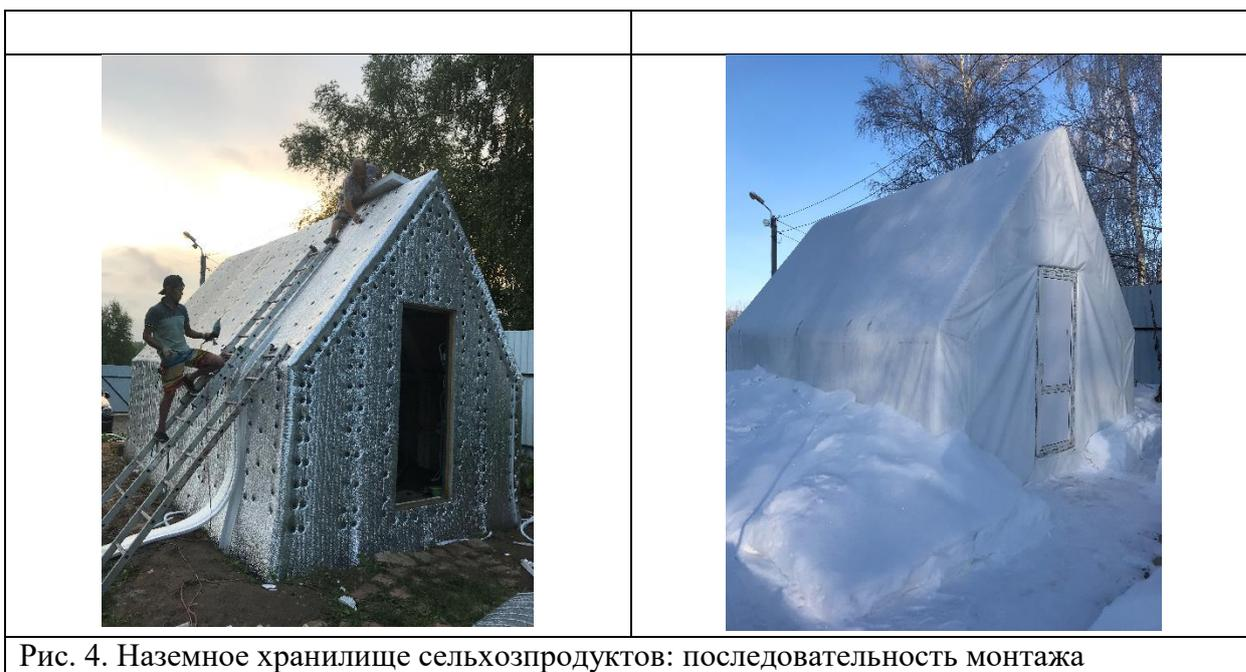
Рис. 4. Наземное хранилище сельхозпродуктов: последовательность монтажа
